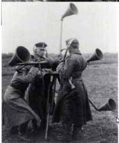
L'avvistamento aereo a distanza veniva effettuato nella prima guerra mondiale con apparati acustici abbinati a fotoelettriche come il modello raffigurato nella foto in dotazione al Regio Imperiale esercito austriaco.
