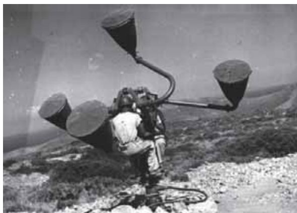
Marinai italiani in azione con l'Aerofono O.G. 41 a Monte Patella sull'isola di Leros, dove vi era anche il muro d'ascolto, 1942.
