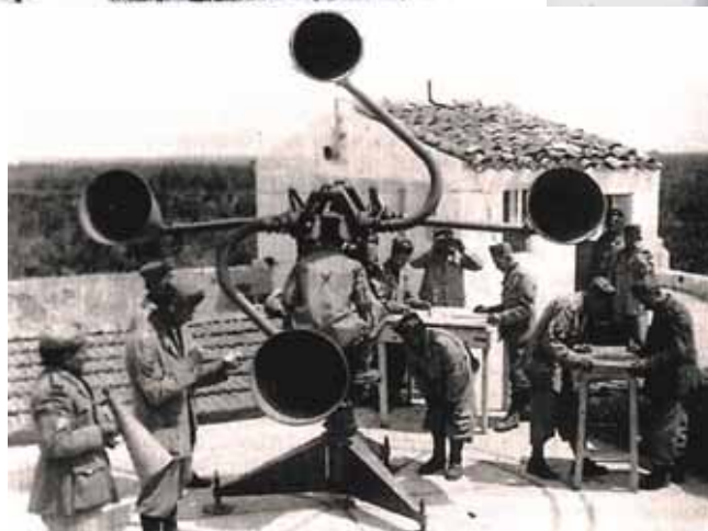
Una postazione di difesa antiaerea ubicata a Casamassima, in provincia di Bari, della 20° Legione della MACA (Milizia Artiglieria Contro Aerea) dotata di Aerofono O.G. 41, 1941.
